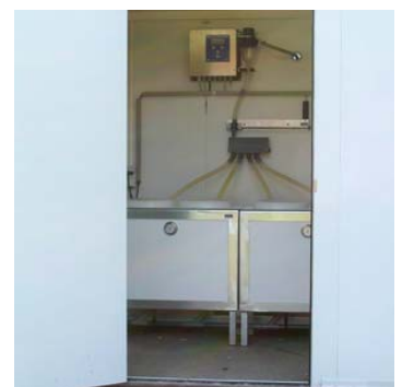
De WS98 vacuüm met X-verdelers toegepast in een ODS Meet- en bemonsteringshuis
