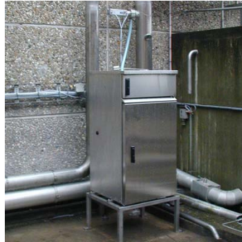
Monsternametoestel uit een RVS loop bij een voedingsmiddelenbedrijf
