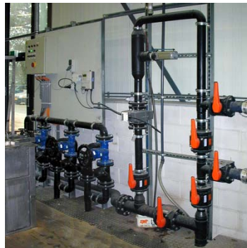
M&B-loop met aansluitingen voor de natte kalibratie
