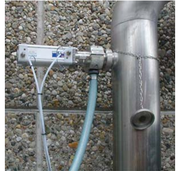
De Plunjermonsternemer wordt geleverd inclusief een afsluitdeksel
