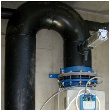
Monsternametoestel vanuit een grote persleiding DN300
