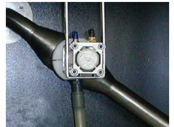
Montage in een DN50 leiding onder een helling. Incl. reducer.
