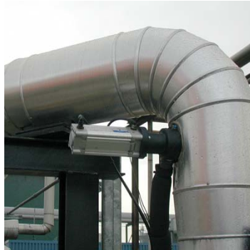
Monstervoerende delen zijn thermisch "getraced".
