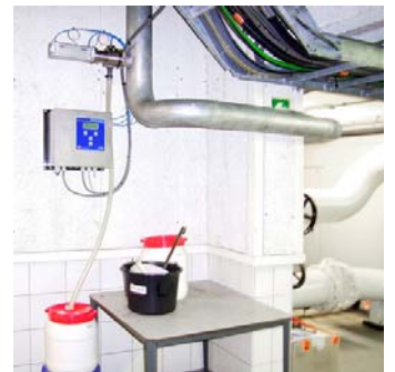
Monsternamete uit een toevoerleiding naar de Sharonreactor.
