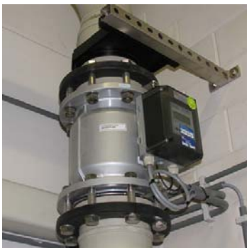
Inductieve flowmeter of elektromagnetische flowmeter
