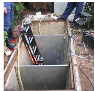
Een natte-droge-natte put in aanbouw
