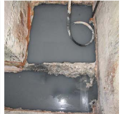
Uit de praktijk. Fout! Niet turbulent, zak in de monsterslang.
