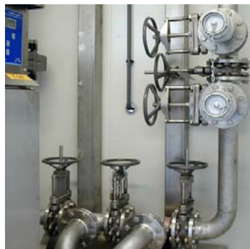
Leidingwerk en afsluiters geheel in RVS uitgevoerd
