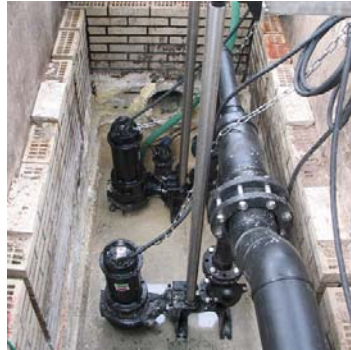
Een oude meetput wordt omgebouwd tot pompput
