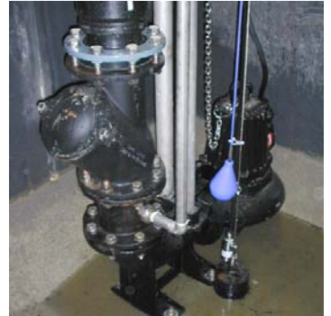
Flytgemaal; pomp, balkeerlep en vlotter.
