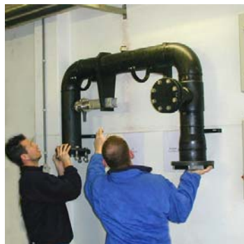
Opbouwen van leidingwerk t.b.v. het in-line meten en bemonsteren
