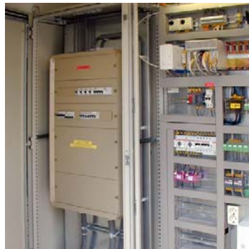
Groepenkast en besturing van een groot pompgemaal
