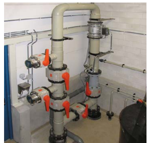
Een meetloop die voldoet aan alle voorwaarden; inclusief aansluitingen voor de natte kalibratie
