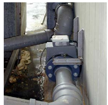
De praktijk van een "meter in verzopen opstelling". De MID meter is een verzamelput van vuil.
