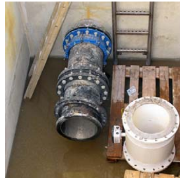
De EMF meter ligt klaar voor montage
