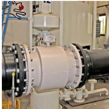
De gemonteerde Elektromagnetische Flowmeter
