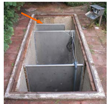
Het slingerschot is nu ook geplaatst
