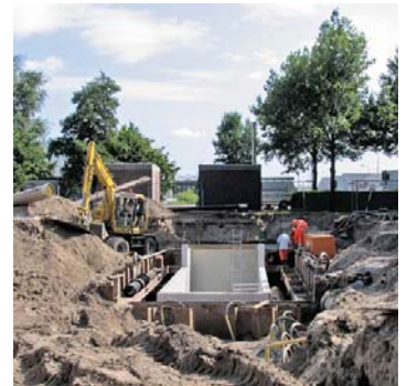
Grondwerk, de put wordt geplaatst
