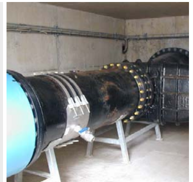
Een grote afsluiter precies voor het instroomtraject "vernield" het stromingsprofiel.
