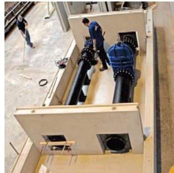
Afmonteren van leidingwerk bij de betonleverancier
