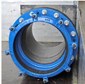
Compensator zodat de meetsectie kan worden uitgenomen
