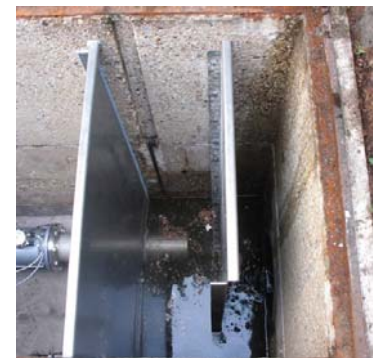
Hier wordt het water ontlicht en zullen delen naar de bodem zakken.
