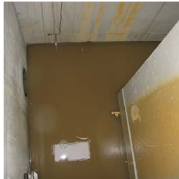
Het slingerschot. Zware delen en gassen worden afgescheiden
