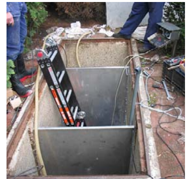
Een natte-droge-natte put in aanbouw
