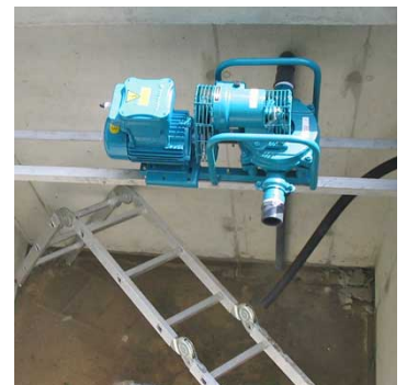
De water/oliepomp voert verontrein- igd water af naar de opvangput
