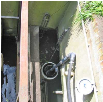
Project met een kleine skimmer en oliefilter en olidedetector
