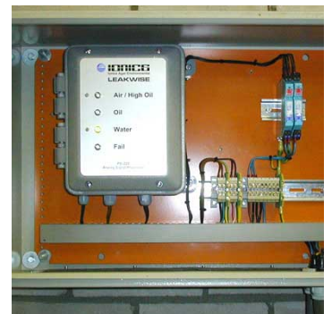
Transmitter model PD-220 met relaiscontacten voor het oliealarm.
