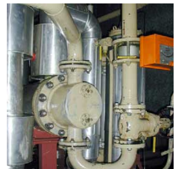
Een monster uit een koelleiding van een warmtewisselaar wordt direct naar de bak gevoerd.
