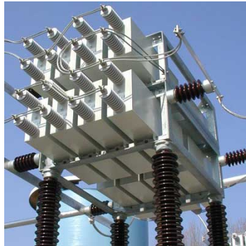
ODS projecten bij Tennet. Hoogspanningscondensatoren.
