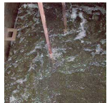
Turbulent water van een energiecentrale. Hier realiseerde ODS een olidedetectie via de bypass methode.
