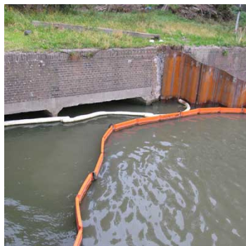
Laatste redmiddel; een oliescherm (oil boom)
