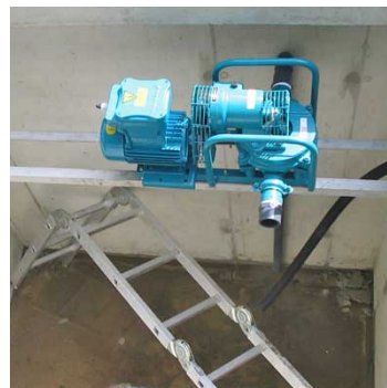
De vuilwaterpomp op een frame boven in de put (in aanbouw)
