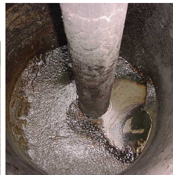
De dikke olie stoort de werking van de sensor niet
