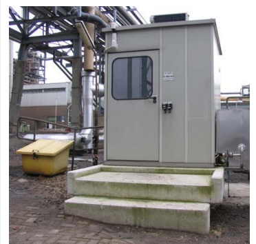
Analyser shelter met TOC-analyser bewaakt effluentwater
