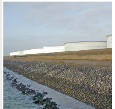
Regenwaterafvoer van een terminal op- en overslag
