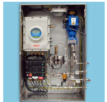
Industriële analyser met conditionering van de druppelgrootte
