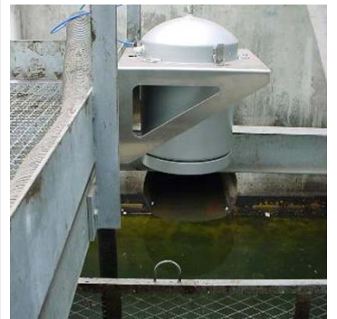
Sensor gebaseerd op de LED of laser reflectiemethode
