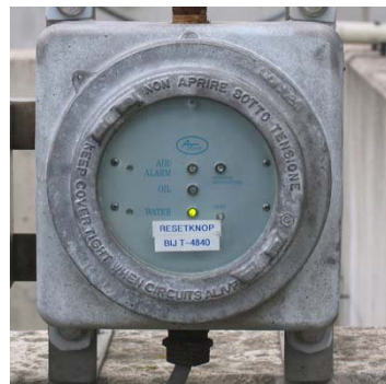
Transmitter PS-220-Eex d is geschikt voor ATEX zone 1
