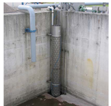
De "stiller" zorgt voor rust in binnenstromend turbulent water
