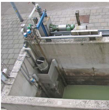
Het bassin met de stiller en de oliedetector
