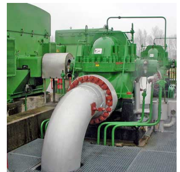
Zware boosterpompen zorgen voor extra transportkracht
