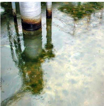
Bij een olielek wordt de regenwaterpomp direct uitgeschakeld
