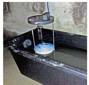
In de kruipruimte bevinden zich de oliedetector en overloopbak
