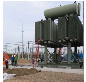
Het nieuwe hoogspanningsverdeelstation in aanbouw
