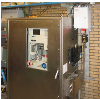
Quick-COD-o analyser met een meetbereik van 500 ppm
