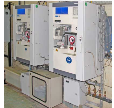
2 stuks Quick-COD-o analysers opgesteld in de veilige zone
