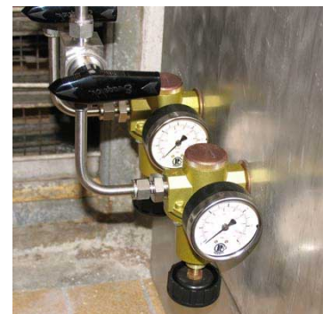
Inlaat reduceren/manometers voor Koellucht en Spoellucht
