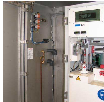
Interieur EEx-p cabinet Analyser met robotarm
