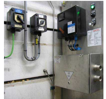
Bartec overdruksysteem en vortec cooler
