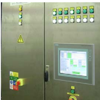
De besturing van de analysers en de pompen in de putten
