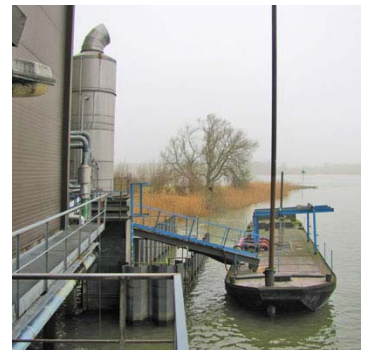
Het effluentpunt lost op de rivier
