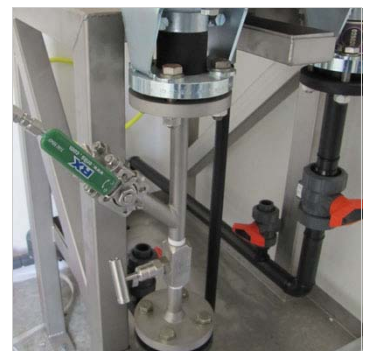
Via een 45 graden aansluiting worden grove delen afgescheiden
