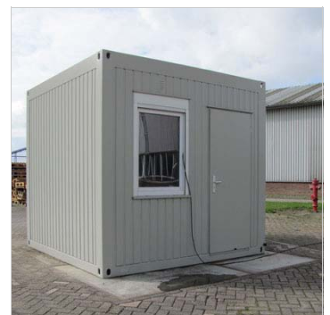
Het analysehuisje biedt plaats aan de analyser en de slangenpomp
