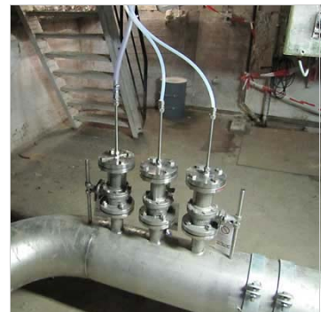
De aansluitingen van de fast sample loop en de sampler
