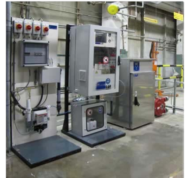
V.l.n.r.: verdeelinrichting, TOC-analyser, monsternametoestel
