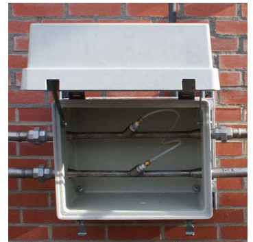
2-strooms monsterextractie; simpel en onderhoudsvrij
