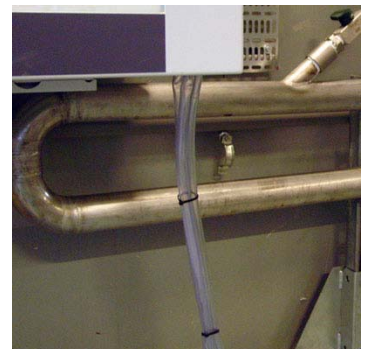
"Fast sample loop" met anti-isokinetische monsternamen
