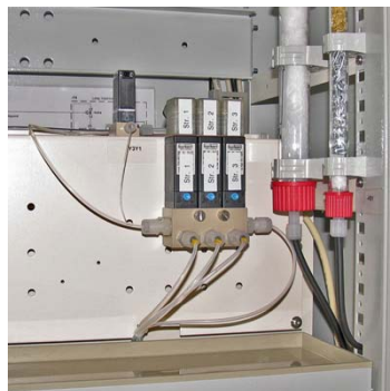
3-strooms meetpuntomschakelaar met manifold
