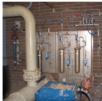
Monsterconditionering voor een 3-strooms TC-analyser
