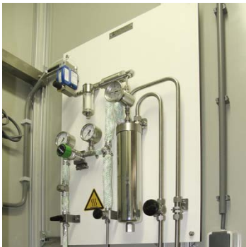
ODS monsterconditioneringssysteem met watercooling
