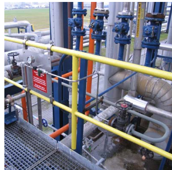
Monsternamen en filterunit met primair filter, manometer en afsluiter
