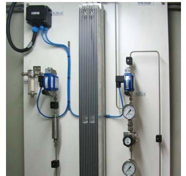
ODS monsterconditioneringssysteem met luchtcooling
