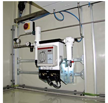
Instrumentenlicht wordt gereinigd via een onderhoudsarme zero air supply
