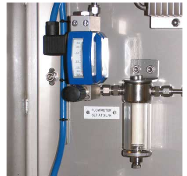
Flowmeter van de monsterstroom met laag-alarm en deeltjesfijnfilter
