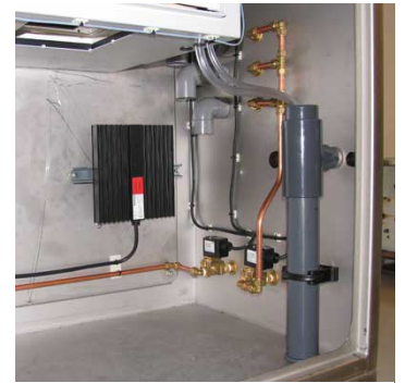
Waterslot; afvoer van overtollig water zonder luchtlek
