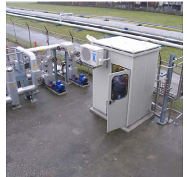
Analyser shelter met airco
