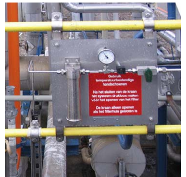
Het primair filter voorkomt vervuiling van de monstertransportleiding
