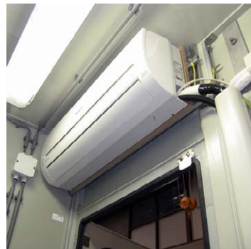
De Airco koelt het geheel gesloten analysehuis (zilte zeelucht).
