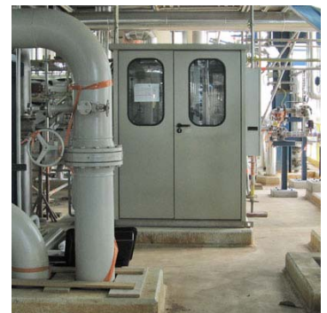
Kunststof Analyser Cabinet met rechts de airco
