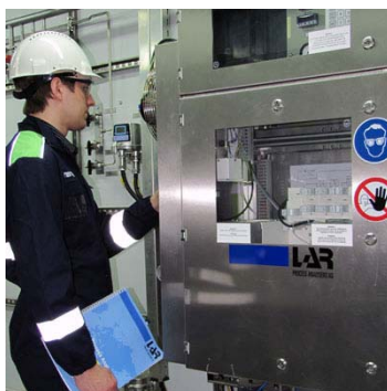
Inspectie en bediening kan plaatsvinden zonder de kast te openen
