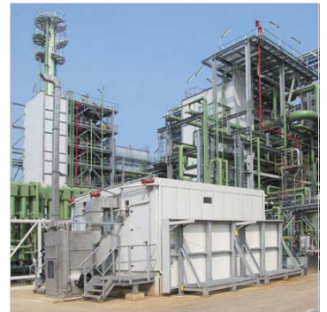
De TOC-analyser staat opgesteld in dit analyser shelter
