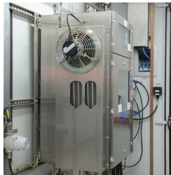
De Ex-analyser wordt via een warmtewisselaar met lucht gekoeld
