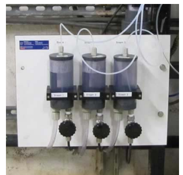
De hoeveelheid condensaat wordt geregeld met een naaldventiel
