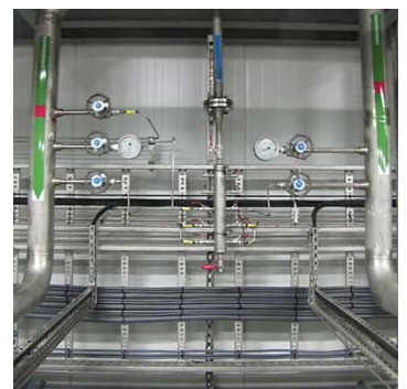
Aftakkingen van de twee retourcondensaatstromen
