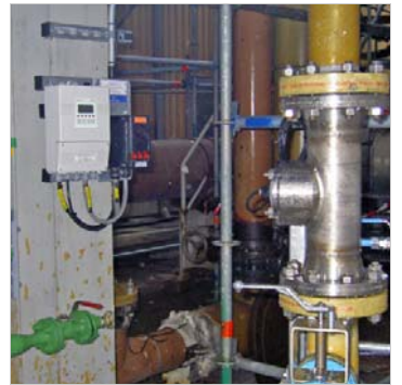
In-line troebelheidsanalyse met de T-30 sanitaire sensor
