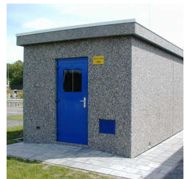
Een analyserhuis waarbij de FCI flowschakelaar toegepast wordt.
