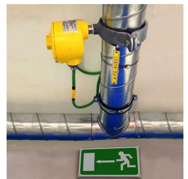
Model FLT 93 is eenvoudig in te bouwen in een afzuigkanaal.
