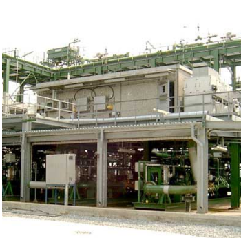
Analysehuis geïntegreerd in een chemische installatie.
