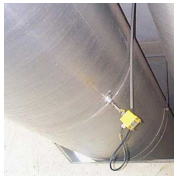
Meten van hele vochtige lucht van een composteringsinstallatie
