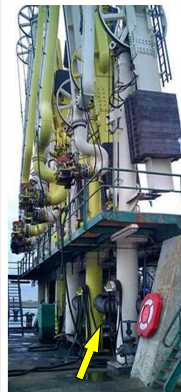
De laadarm met de procesleiding en vloeistofschakelaar
