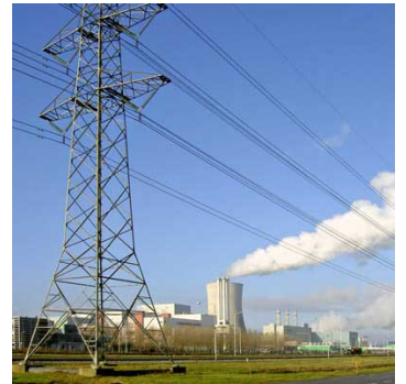
Afvalverbranding Zuid-Nederland te Moerdijk
