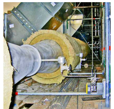
Aanbrengen van isolatie om de meetstraten
