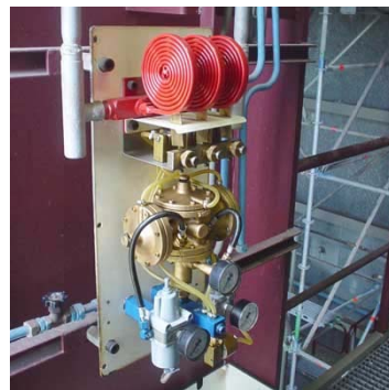
Binnenwerk van een SiZ 5300 met bourdonveren
